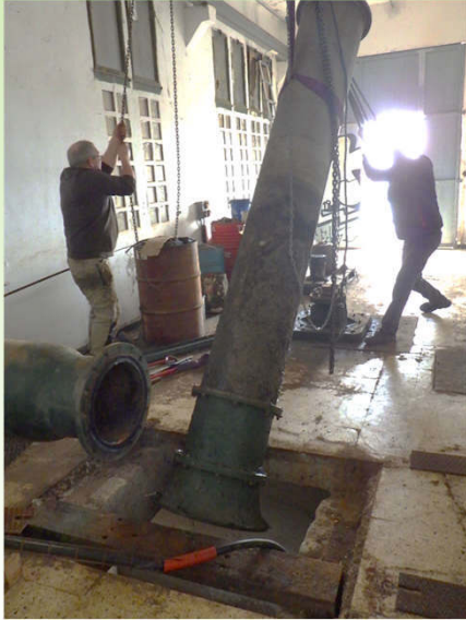
Station des Drilles Dépose de la pompe pour le remplacement de l'hélice et de l'arbre de transmission
