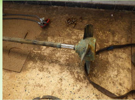
Station des Drilles Dépose de la pompe pour le remplacement de l'hélice et de l'arbre de transmission
