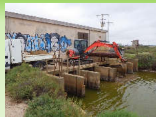
Condamnation d'une entrée d'eau saline sous le bâtiment
