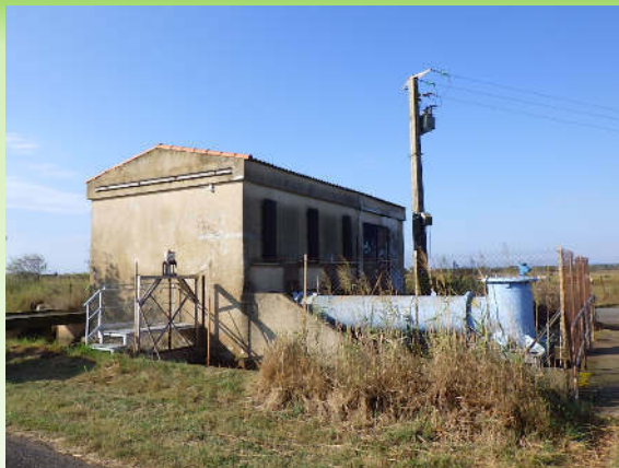
Station St Génies Remplacement de la passerelle
