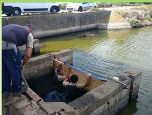
Condamnation d'une entrée d'eau saline sous le bâtiment
